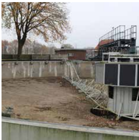
Een van de bakken op het terrein van de waterzuivering
