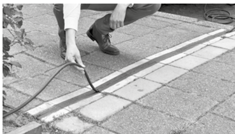
De oplaadkabels kunnen weggewerkt worden in een speciaal gootje in het trottoir
