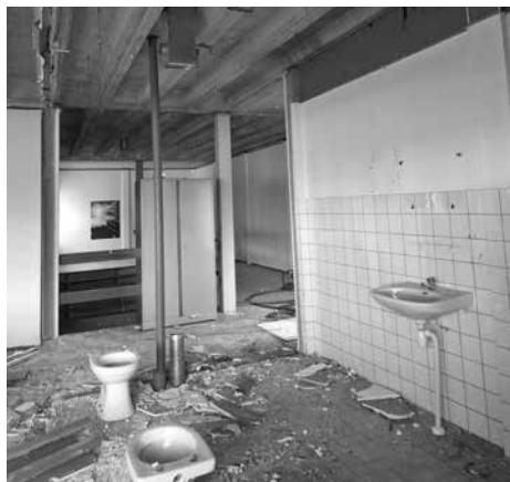
Er wordt volop gesloopt aan de St. Josephstraat 106
